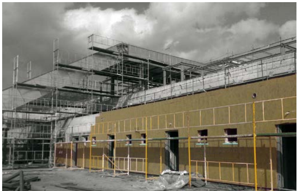
Θερμομόνωση μεταλλικών φύλλων πλαγιοκάλυψης
