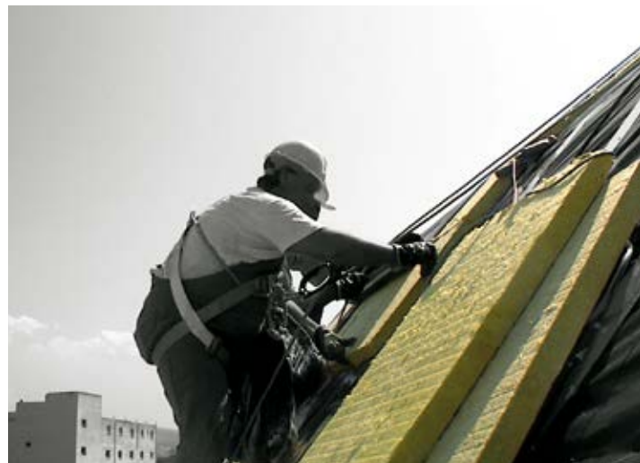
Θερμομόνωση κεκλιμένης στέγης μεταξύ δυο μεταλλικών φύλλων επιστέγασης με διπλή στρώση πετροβάμβακα FIBRANgeo BP-40 και BP-50
