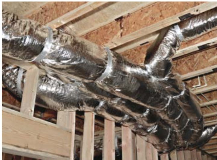
Θερμομόνωση αεραγωγών με FIBRANgeo R-040-AL
